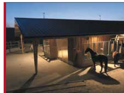
Monterat i stabli byggnad med tak
